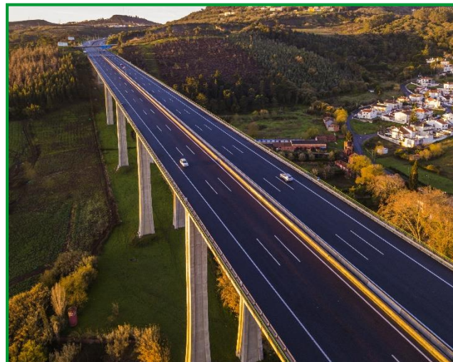
A9 – Viaduto de Loures
